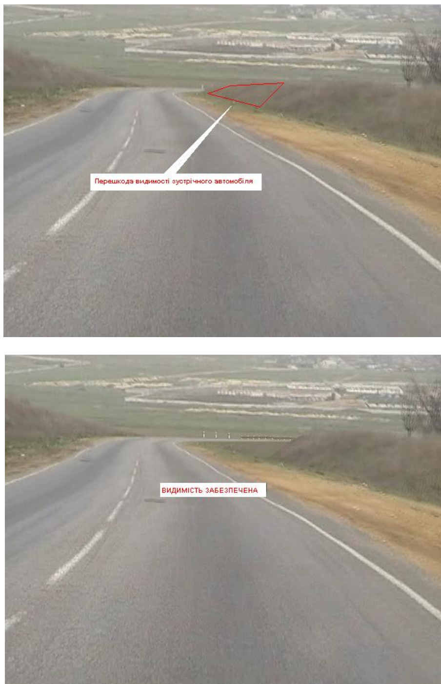
Рисунок 6.5 – Приклад невиявленої закритої видимості на дорозі II категорії при R=1000 м, з похилом 7 ‰
